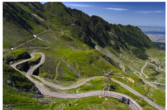
Carretera Transfagarasan – Càrpats-
